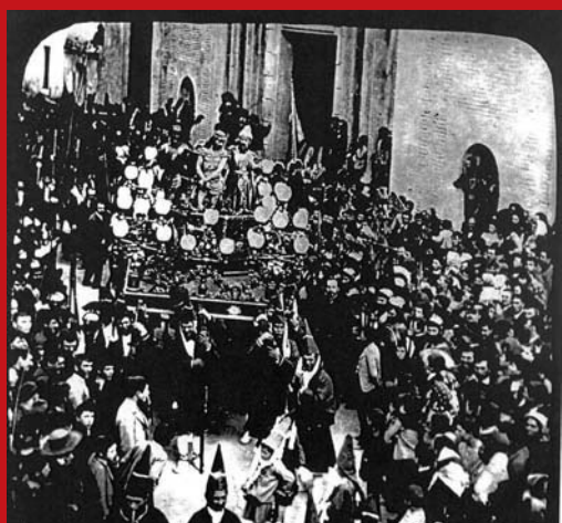
Foto 6: Obra de Nicolás de Bussy, este paso de El Pretorio fue parcialmente destruido en 1936, conservándose hoy del original solamente la imagen del Redentor (1695-6).
