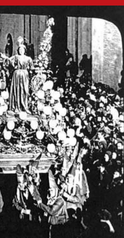
Juan con el Carmen al ar hacia la Alameda de cada por Baglietto 'el 46, fue destruida durante
