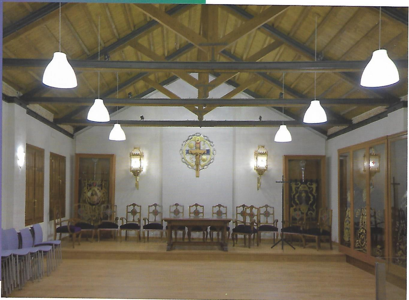
Sala de Juntas en el piso superior tras la reforma de la cubierta con la madera vista.
